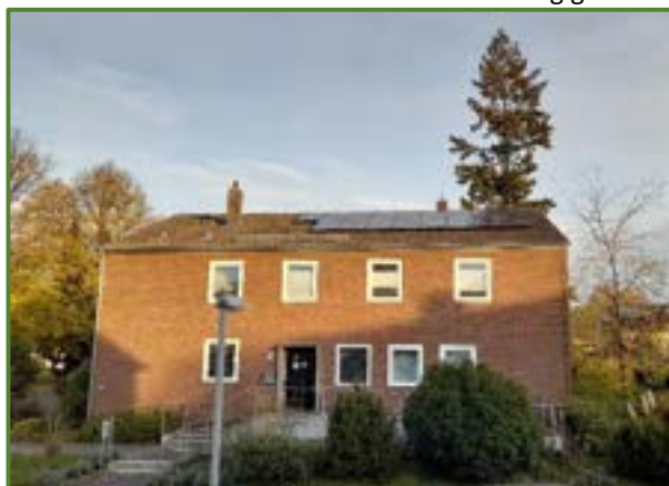
Das Solardach auf dem Pfarrhaus von Heilig Geist in der Abendsonne eines Novembertags
